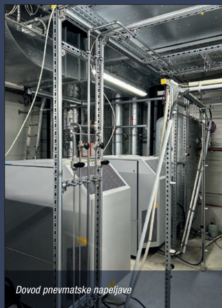
Tridimenzionalna pritrdilna mreža za območja z visoko gostoto namestitve in visokimi zahtevami po prilagodljivosti.
